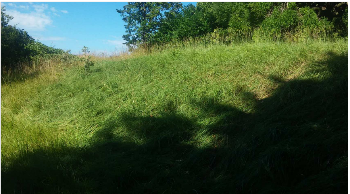
Una scarpata di evidente origine antropica a SE del fabbricato principale, realizzata per un verosimile accumulo di terreni di riporto
